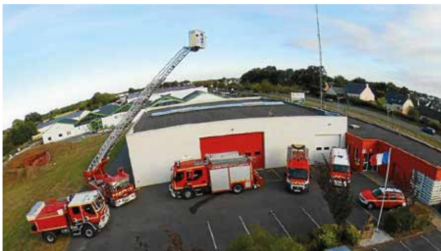
Centre de secours de Questembert
